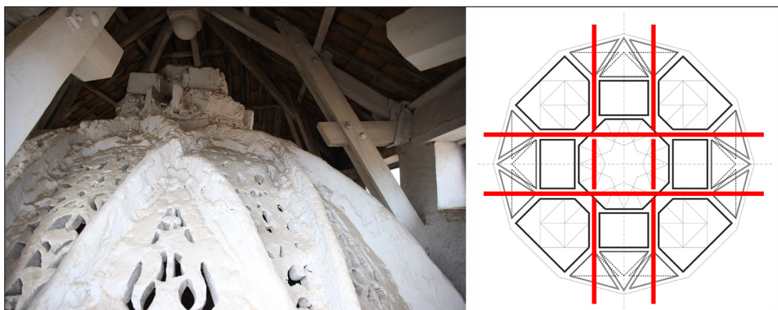
Fig. 18. Fotografía del trasdós de la bóveda y cupulín que cubre la maqsura de la Mezquita Mayor de Tremecén en Argelia, y esquema en planta de prismas y medinas del cupulín y posible disposición de los tableros que se ven en la fotografía.
