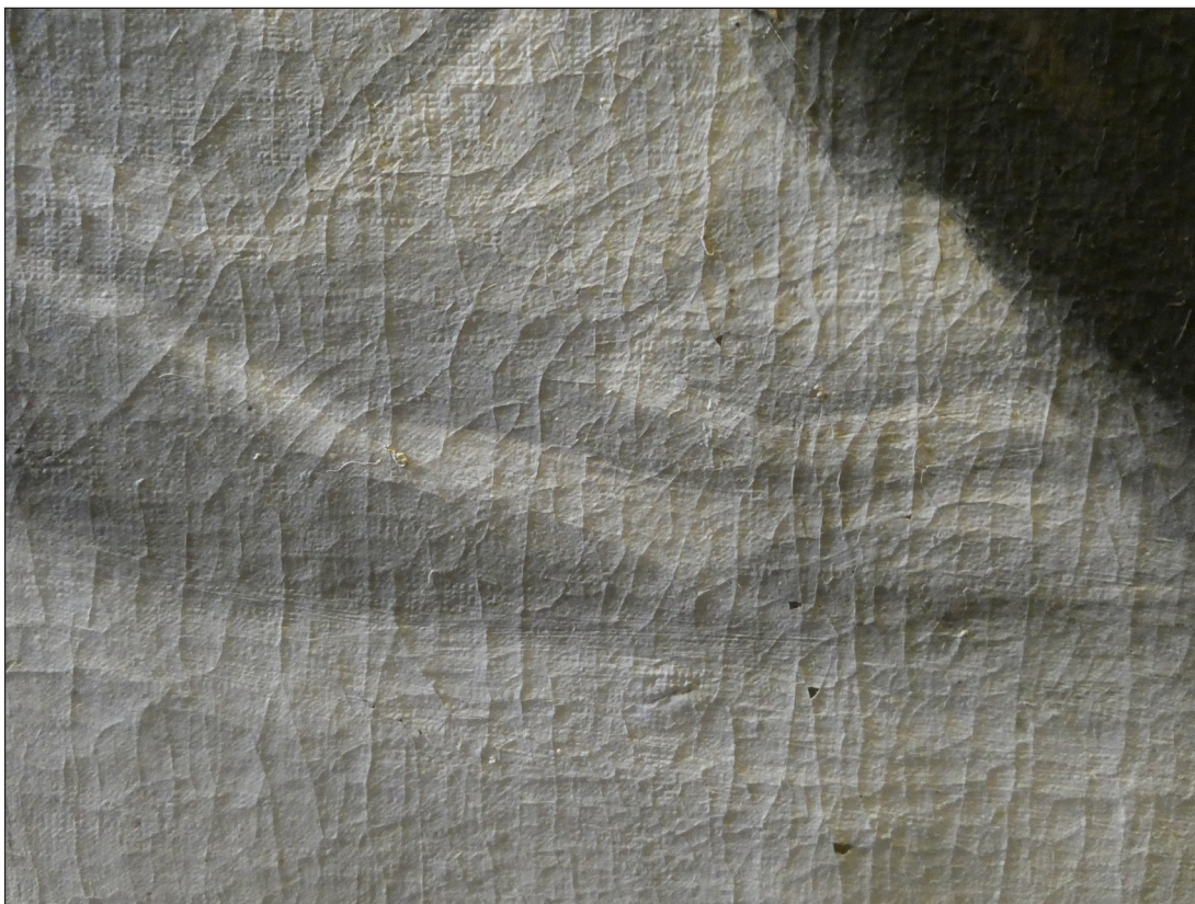
Fig. 4. Lesiones en la epidermis de la obra, craqueladuras muy pronunciadas.
