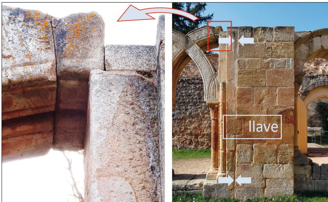
Fig. 57. Macizo oeste visto desde patio. Detalle de apoyo del arco califal en este macizo.
