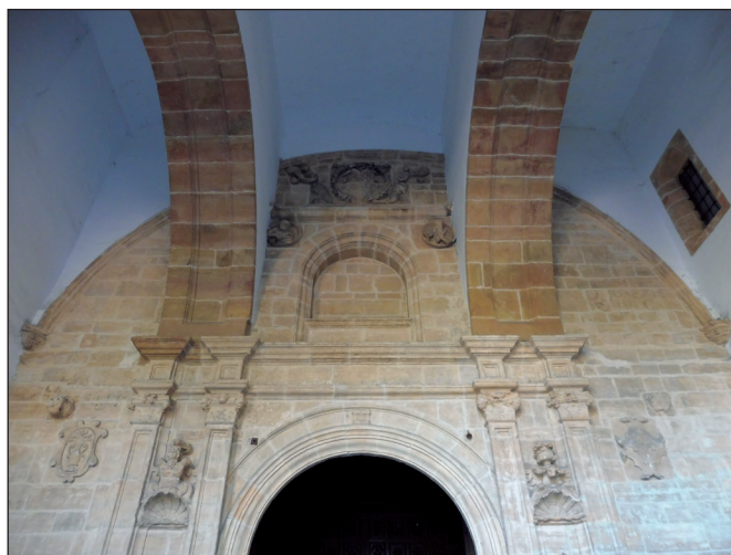
Fig. 5. Manuel Reguera, atrio de la iglesia de Nuestra Señora del Rosario (convento de padres dominicos, Oviedo), 1768. Detalle de las bóvedas y arriostamiento de la fachada quinientista. Fotografía del autor (abril 2024).
