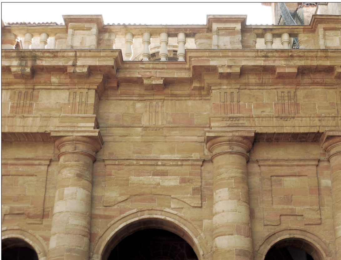
Fig. 9. Detalle del remate de las semicolumnas, entablamento, cornisa y balaustrada de la fachada-atrio de la iglesia de Nuestra Señora del Rosario. Fotografía del autor (abril 2024).
