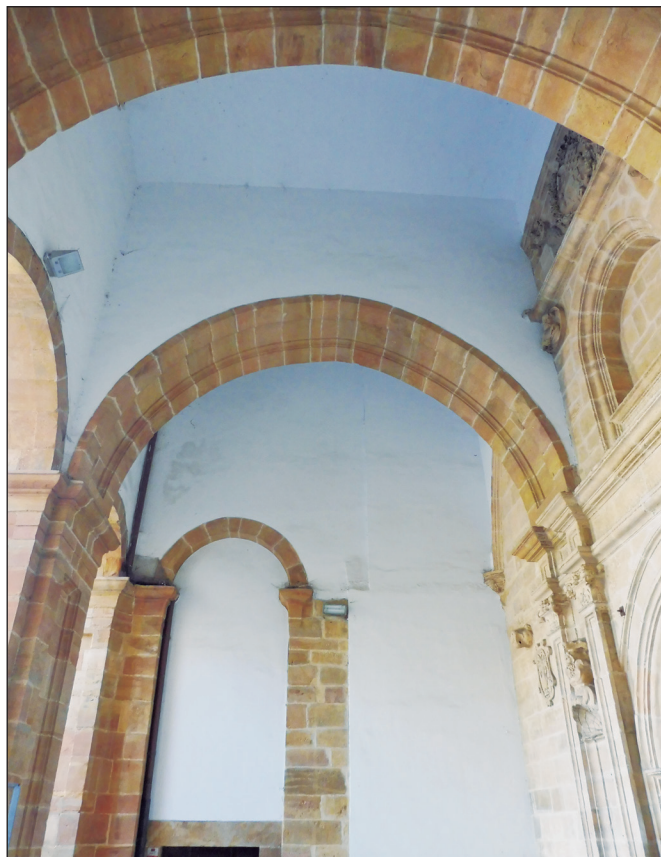
Fig. 4. Manuel Reguera, atrio de la iglesia de Nuestra Señora del Rosario (convento de padres dominicos, Oviedo), 1768. Detalle de los arcos de descarga y del arco septentrional cegado. Fotografía del autor (abril 2024).
