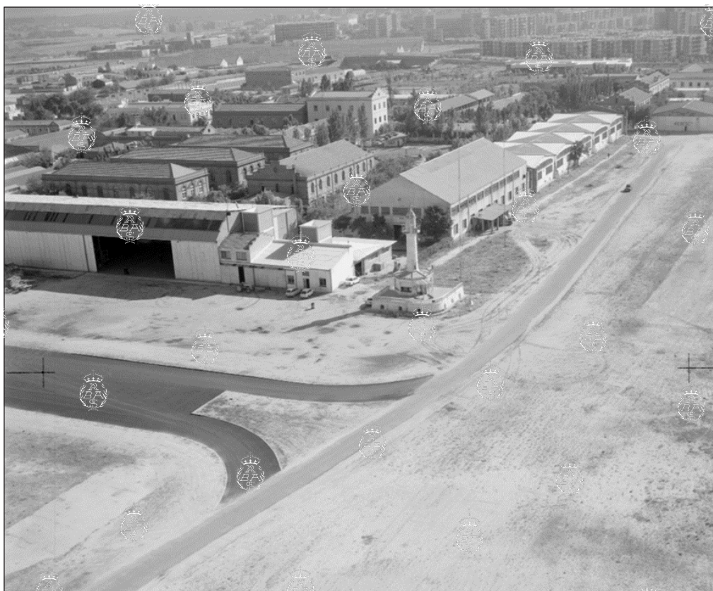
Emplazamiento de la Torre de Señales del aeródromo de Cuatro Vientos.
