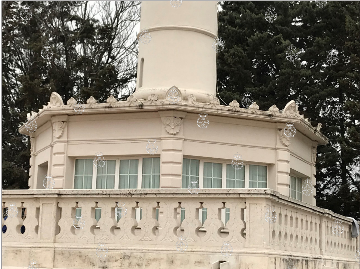
Aspecto actual del cuerpo bajo de observación, al nivel de la terraza de la Torre de Señales, en la que se ha rebajado la altura original de los dinteles de los huecos. Foto P. Navascués (marzo 2021).
