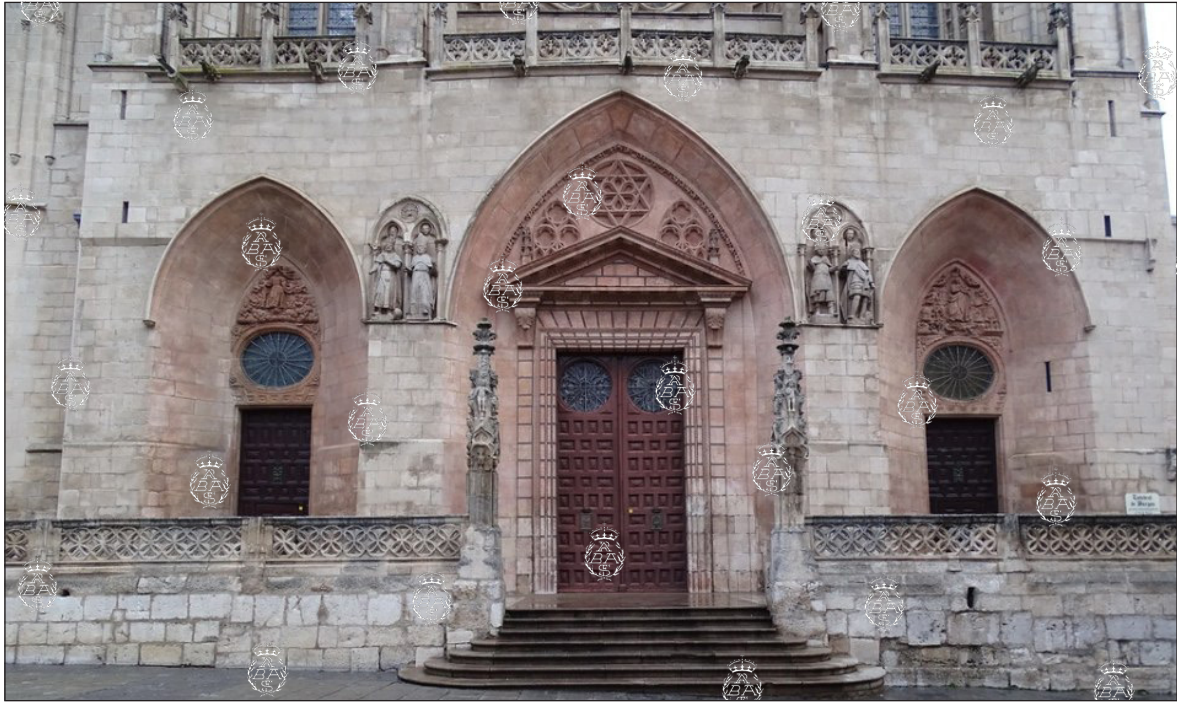
Catedral de Burgos, aspecto actual de la parte inferior de la fachada de Santa María. Obsérvese los óculos abiertos en las hojas de la puerta central para dar luz al interior.
