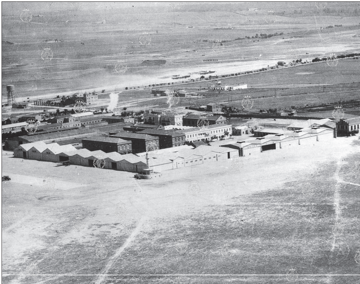
Situación de la Torre de Señales respecto a los edificios del Parque Central que componen el núcleo primero del aeródromo de Cuatro Vientos (1920-1930).
