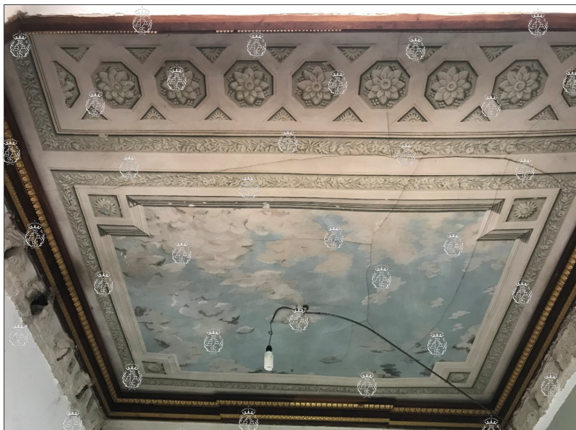
Estado actual, a falta de la restauración pictórica. Foto: P. Navascués (abril, 2021).
