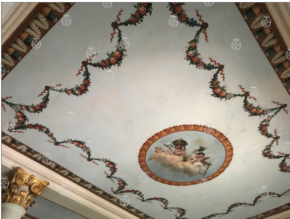
Techo pintado del dormitorio principal, adornado con guirnaldas ejecutadas sobre papeles de colores, recortados y pegados. Foto: M. C. Utande (abril, 2021).
