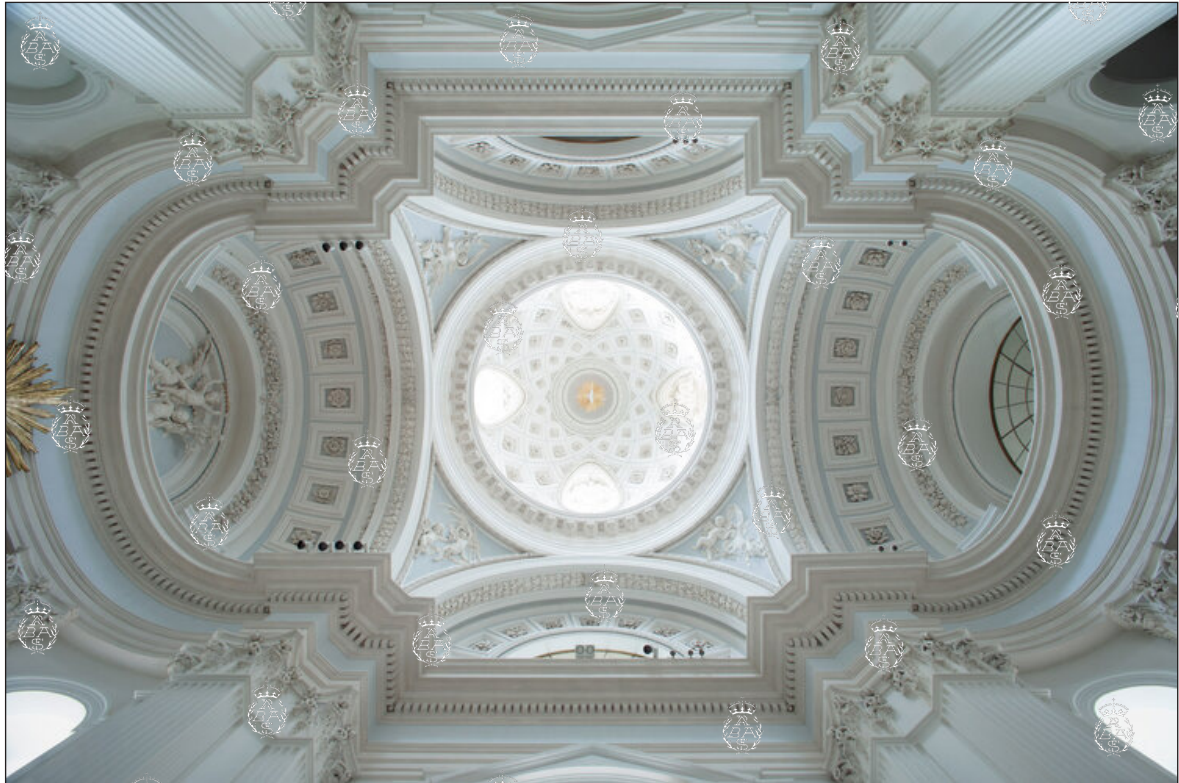
Palacio de Boadilla del Monte. Bóvedas restauradas de la capilla. Foto: Estudio J. R. Duralde.
