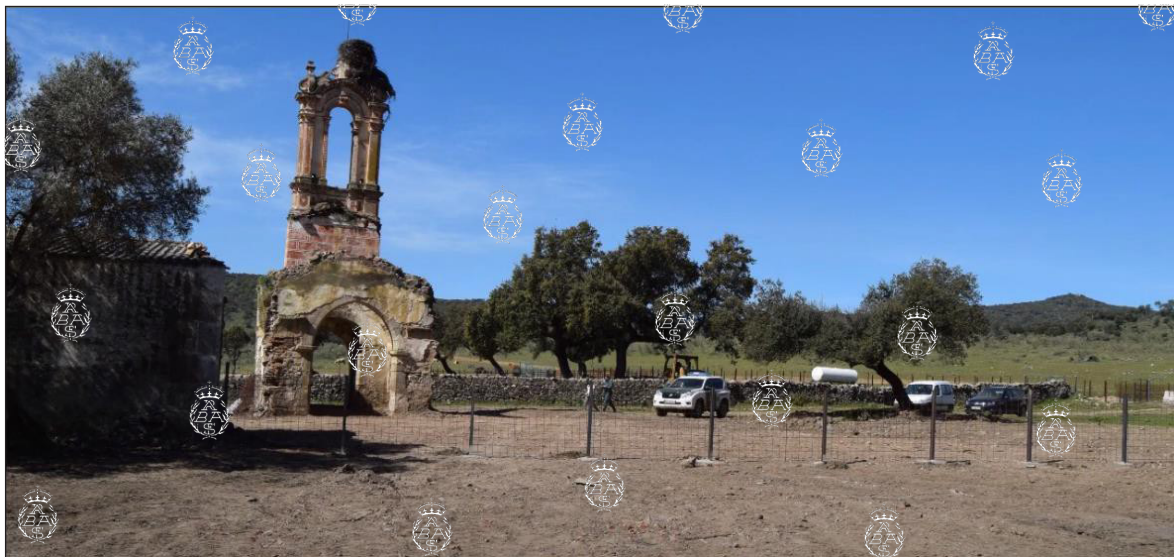
Estado actual de la ermita de Santa María de Brovales. Foto facilitada por la Concejalía de Cultura de Jerez de los Caballeros.
