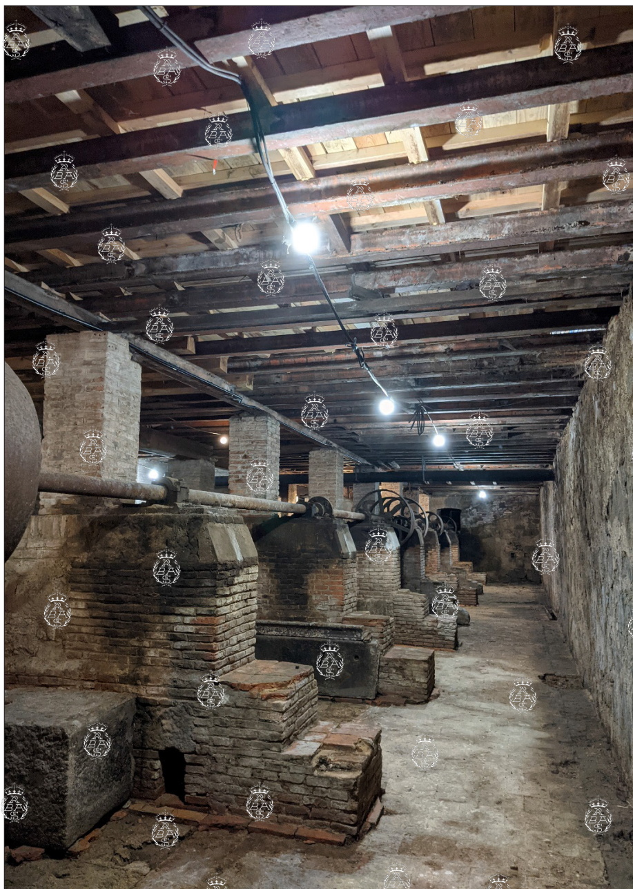
Planta baja con los apoyos de la maquinaria. Foto: P. Navascués.
