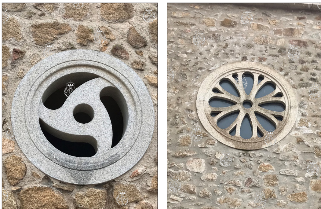
Hueco de nuevo diseño abierto en la base de la torre (izquierda), y nuevo óculo que ilumina la nave central por encima del coro (derecha). "Singularidades" de la restauración.
