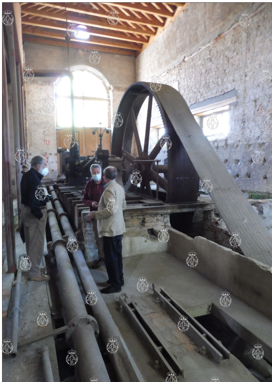
Sala de la máquina de vapor, dejando ver el subsuelo, eliminado el piso. Foto: E. Nuere.
