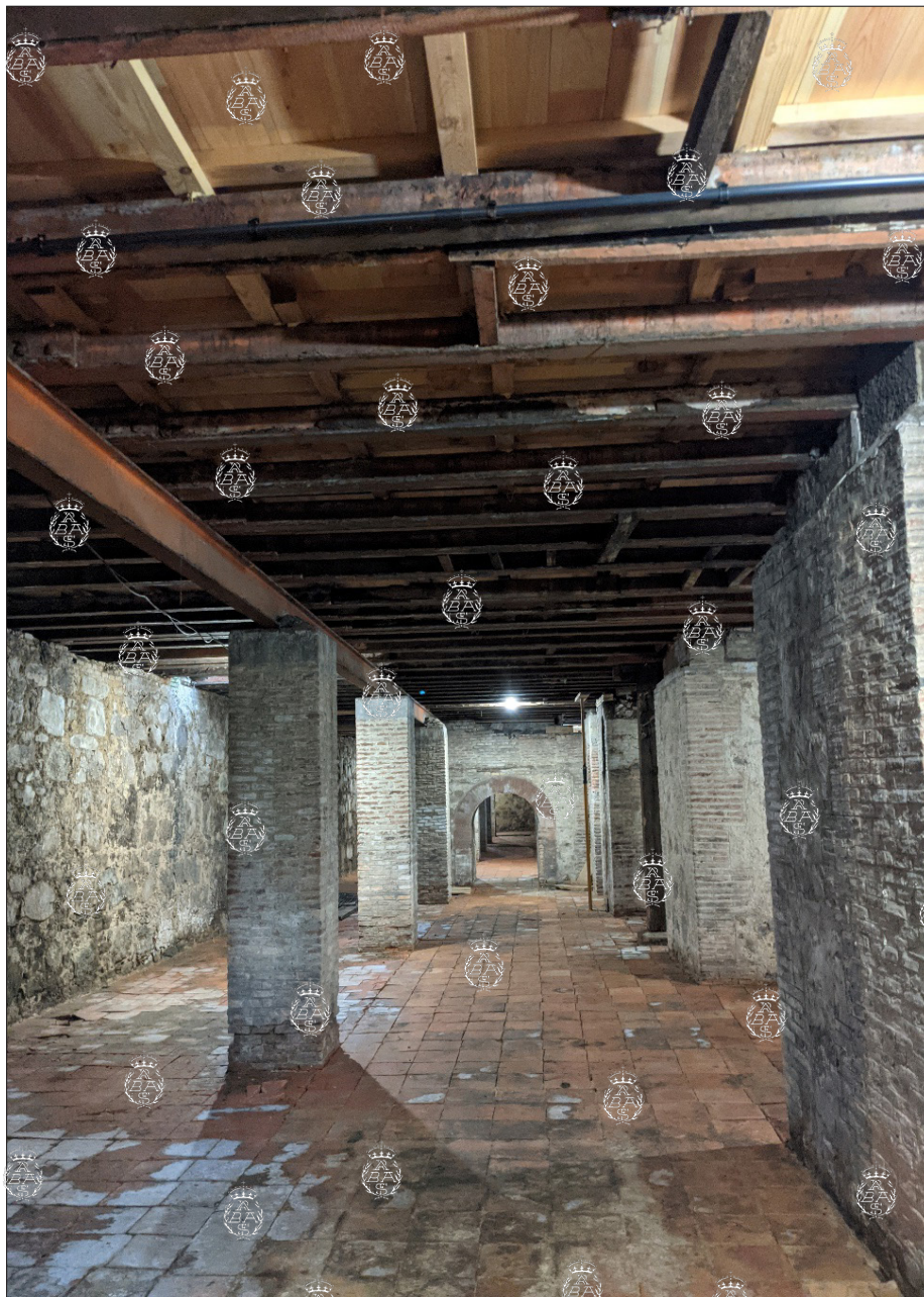
Planta baja del Aserrío. Foto: P. Navascués.
