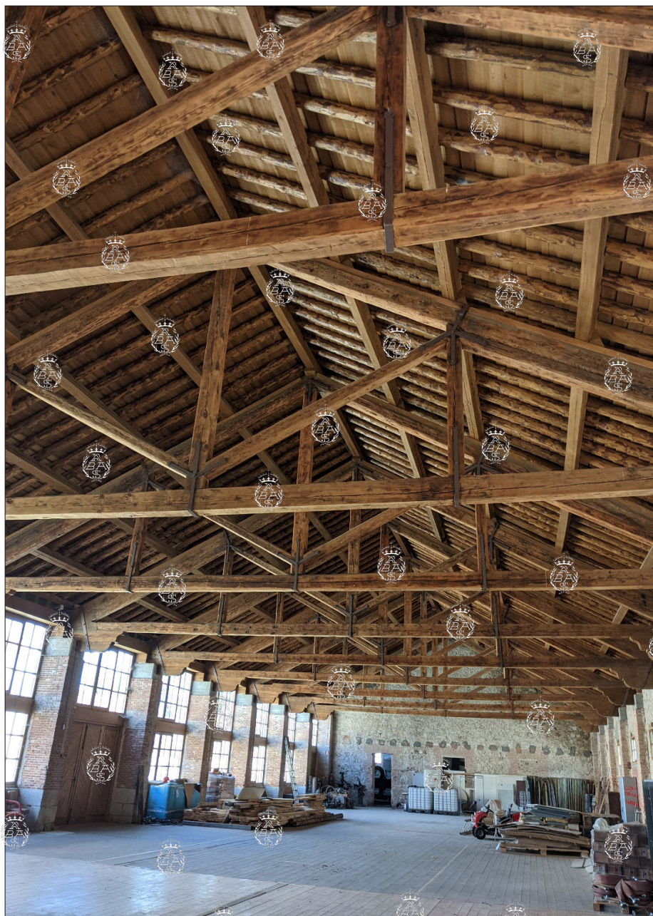
Antigua sala de máquinas del Real Aserrío. Foto: M. C. Utande.
