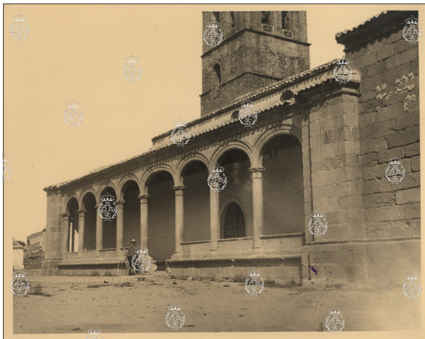
Fachada sur de la iglesia de Nuestra Señora de las Nieves en Manzanares el Real (Madrid). Fondo fotográfico Muguruza, sign. Fot-Mug-1614, Archivo de la RABASE. Estado original del pórtico, sin el actual cerramiento enrejado, y quiebro de la cubierta con dos pequeños tragaluces sobre la nave de la Epístola. Entorno "sin ajardinar".
