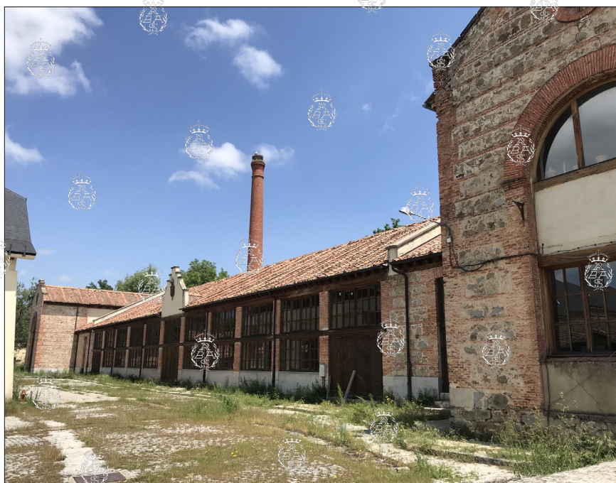
Fachada principal del Real Aserrío. Foto: E. Nuere.
