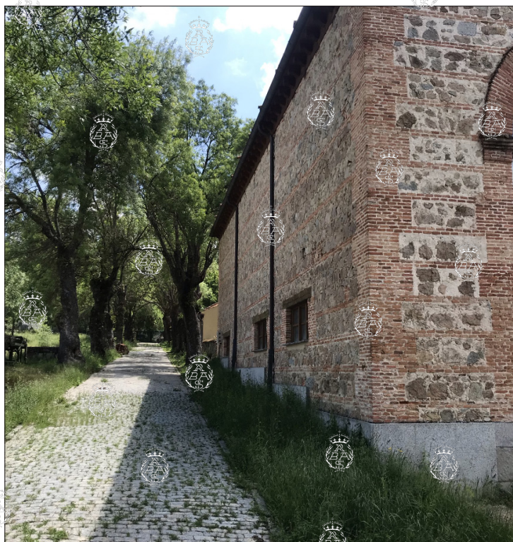
Fachada lateral de la sala de la máquina de vapor y paseo inmediato. Foto: P. Navascués.
