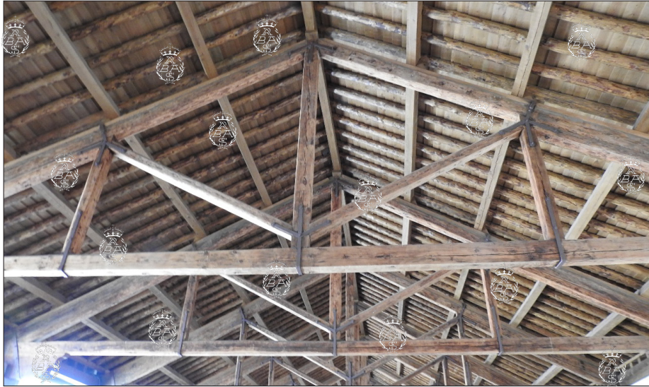
Detalle de la cubierta de cuchillos triangulados. Foto: C. Muñoz de Pablos.
