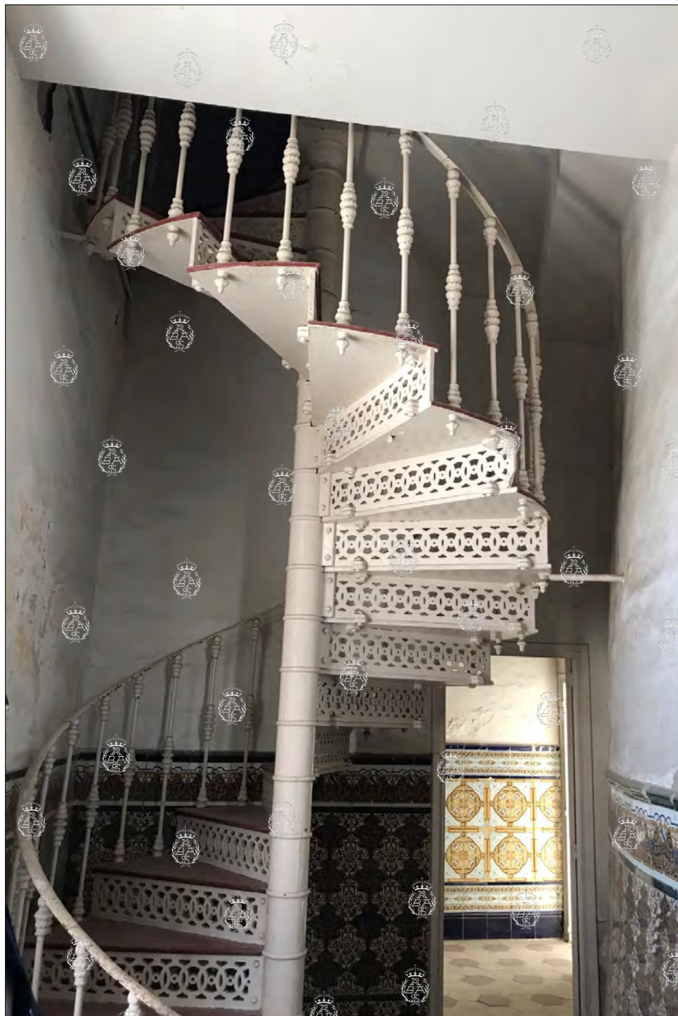
Detalle de una de las escaleras de la antigua vivienda del farero. Foto P. Navascués / M. C. Utande.
