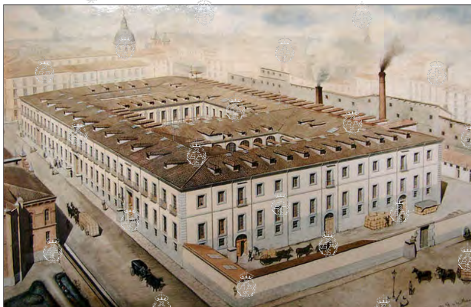
Vista general de la Real Fábrica de Tabacos hacia 1880, por Dionisio Sainz de la Maza. En primer término, el corralón hacia la Glorieta de Embajadores. A la derecha, las chimeneas del motor . A la izquierda, el nuevo edificio de la Escuela de Veterinaria (1877-1881), de Francisco Jareño; actualmente, Instituto de Enseñanza Secundaria Cervantes.
