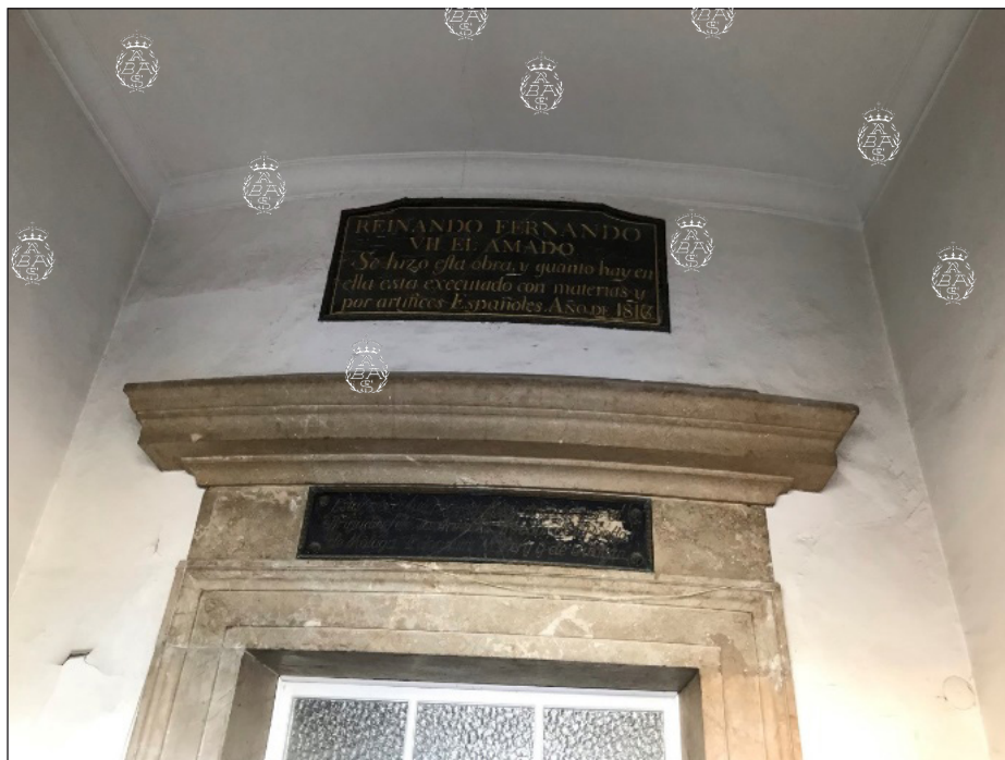
Vista de la puerta original de acceso a la Farola y situación de las inscripciones. Foto P. Navascués / M. C. Utande.
