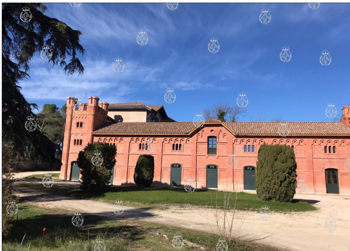
Fachada meridional de las caballerizas de la Quinta de Torre Arias. Foto: M. C. Utande.
