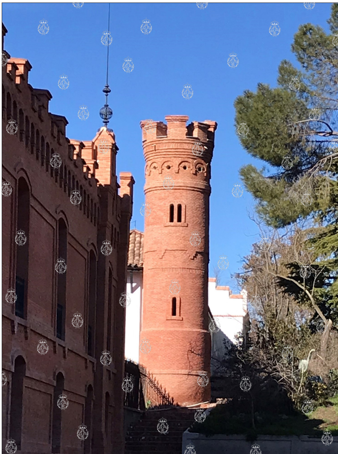
Torreón cilíndrico anejo a las caballerizas y próximo al ángulo noreste del palacio de la Quinta de Torre Arias. Foto: P. Navascués.
