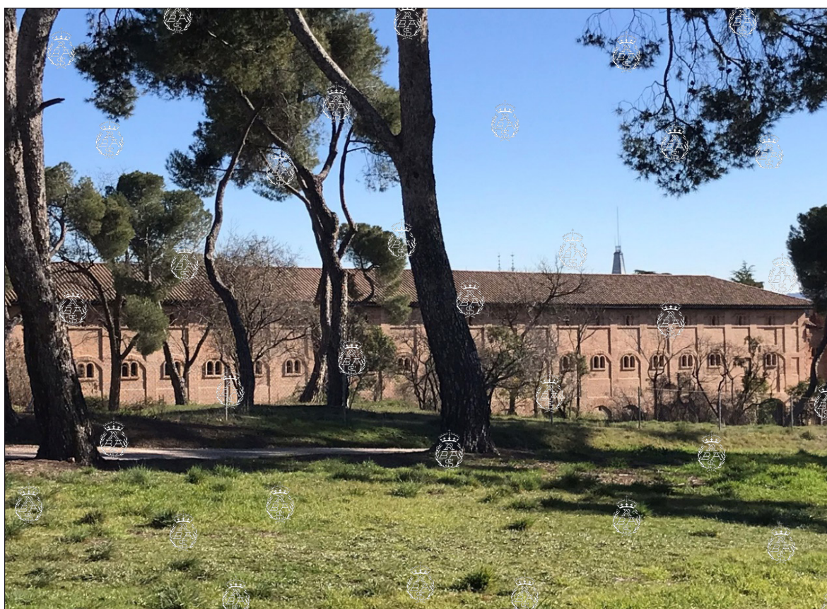
Quinta de Torre Arias. Vista general de la fachada occidental de la ampliación de las caballerizas. Foto: M. C. Utande.
