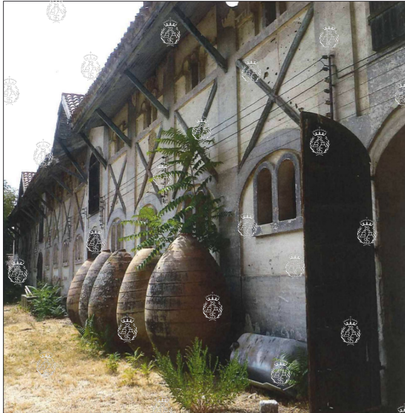
Patio interior de las caballerizas. Foto del Plan Especial de Protección de la Quinta de Torre Arias. Ayuntamiento de Madrid.
