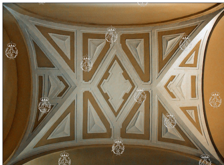
Bóveda restaurada de la nave lateral. Foto: Mario Sánchez Cachero.
