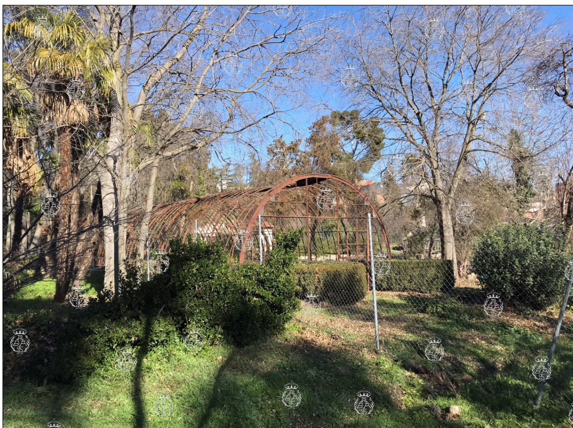
Invernadero metálico de la Quinta de Torre Arias, desde el lado sur. Foto: M. C. Utande.
