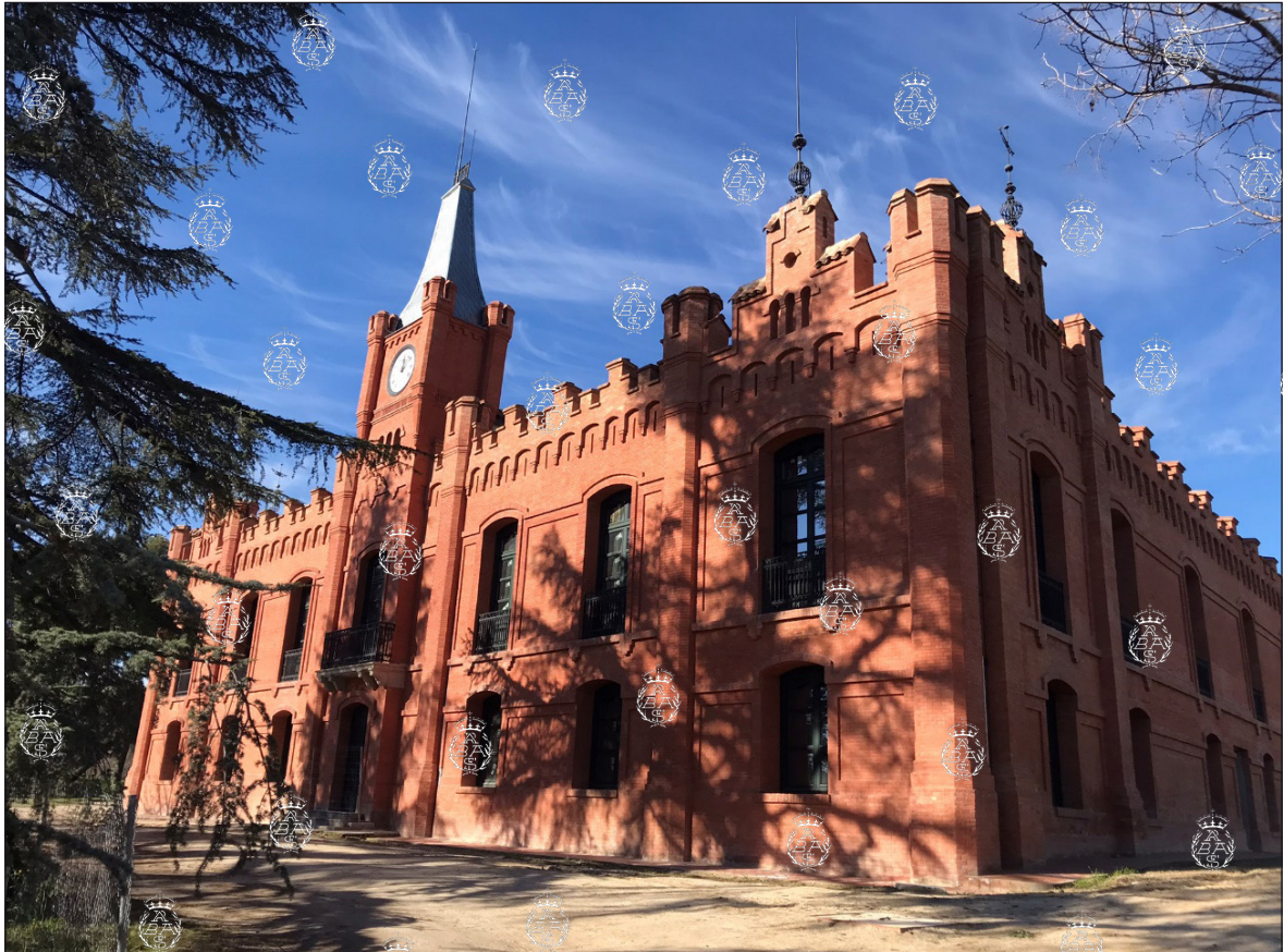
Vista general del palacio de la Quinta de Torre Arias. Fachada principal en su lado sur. Foto: M. C. Utande.
