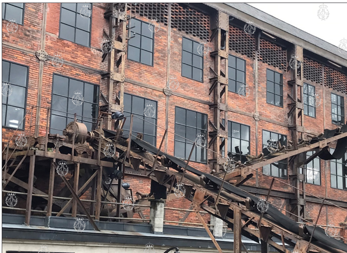
Detalle de una fachada de la nave de calderas dejando vista la estructura metálica. Foto: M. C. Urande.
