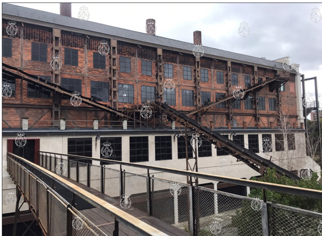
Fachada de la nave de calderas vista desde el descargadero de carbón, de donde parte la cinta transportadora. Foto: P. Navascués.
