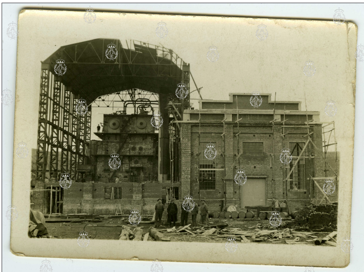
Antigua fotografía de la primera fase de la nave de calderas y nave de turbinas. Foto de la Colección de la MSP.
