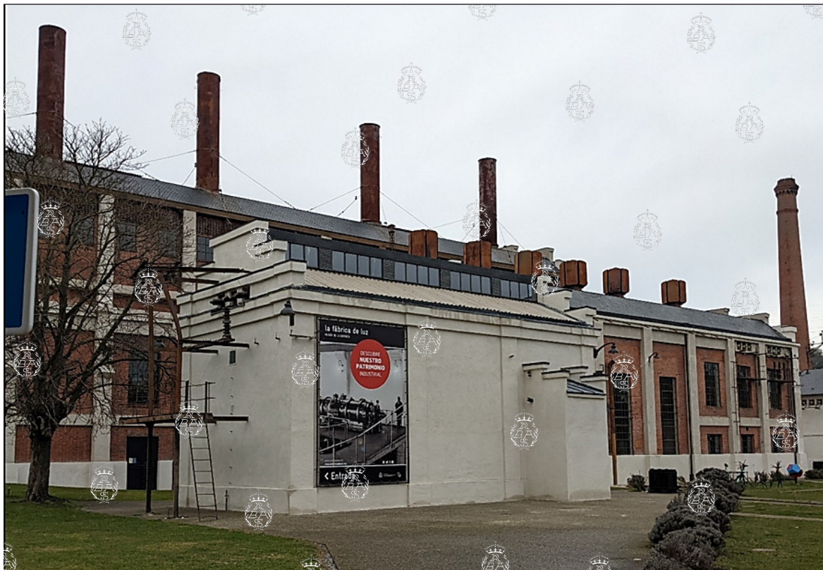
En primer término, el edificio del trafo; la nave de turbinas a la derecha; detrás la nave de calderas con las cuatro chimeneas y, al fondo, la chimenea de la primera central térmica. Foto: M. C. Utande.
