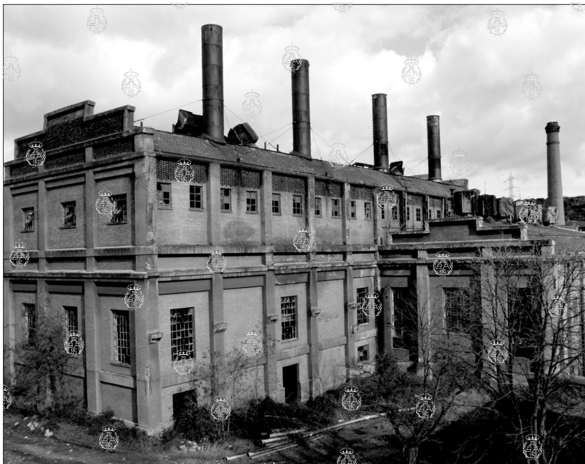
La MSP antes de su rehabilitación y restauración. Foto: autor desconocido.
