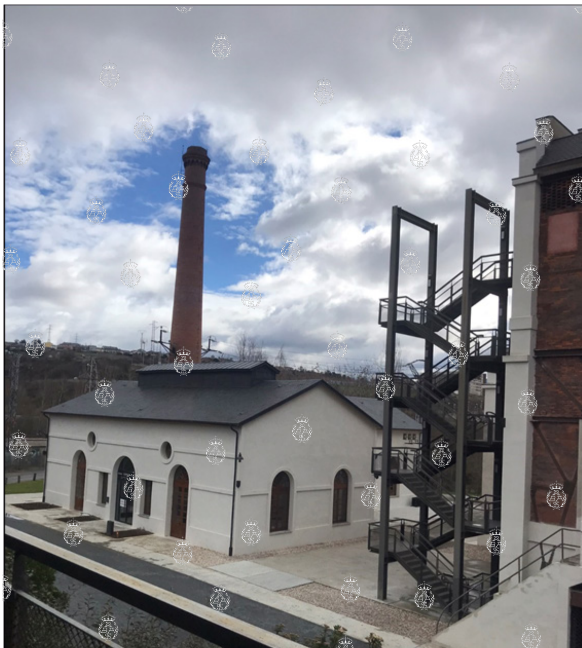
Primer edificio y chimenea de la MSP hacia 1920. Actualmente alberga oficinas y el restaurante “La Central”. A la derecha, escalera de incendios de la nave de calderas. Foto: P. Navascués.
