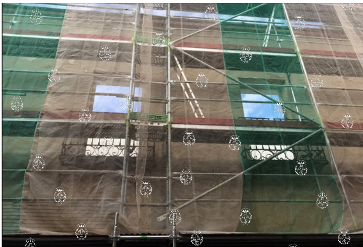
Fachada a la calle Nebrija, durante el proceso de demolición. Foto: M. C. Utande (2019).
