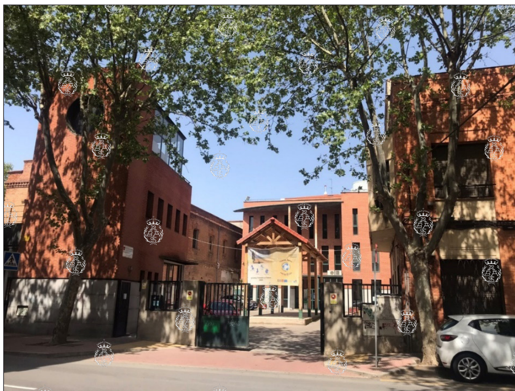
Aspecto de los edificios inmediatos a la fábrica de harinas (Escuela de idiomas, casa de los antiguos propietarios de la fábrica de harinas, etc.), en su entrada por la calle Daoiz y Velarde, 28. Foto: M. C. Utande (2022).
