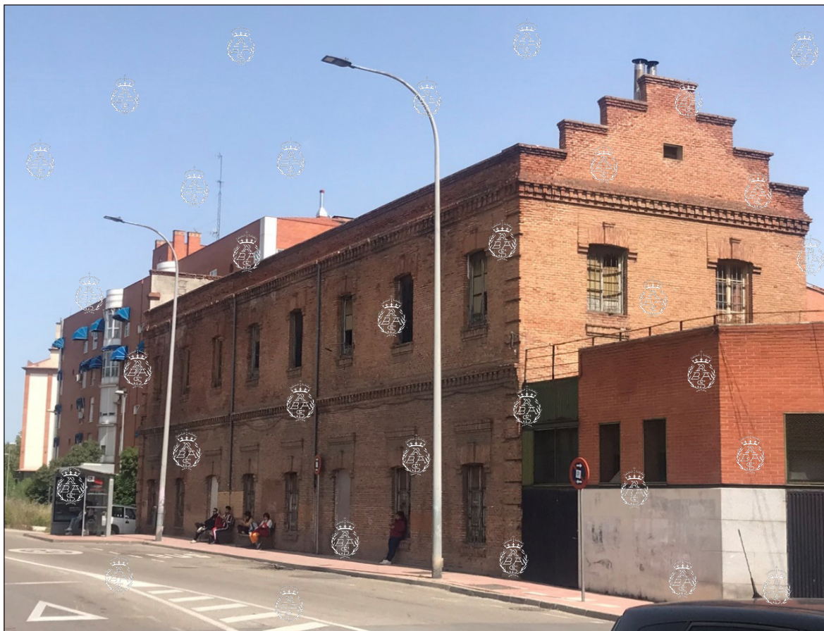
Fábrica de harinas “La Esperanza”, sobre la avda. de Daganzo, antigua carretera de Alcalá de Henares a Daganzo. Foto: P. Navascués (2022).
