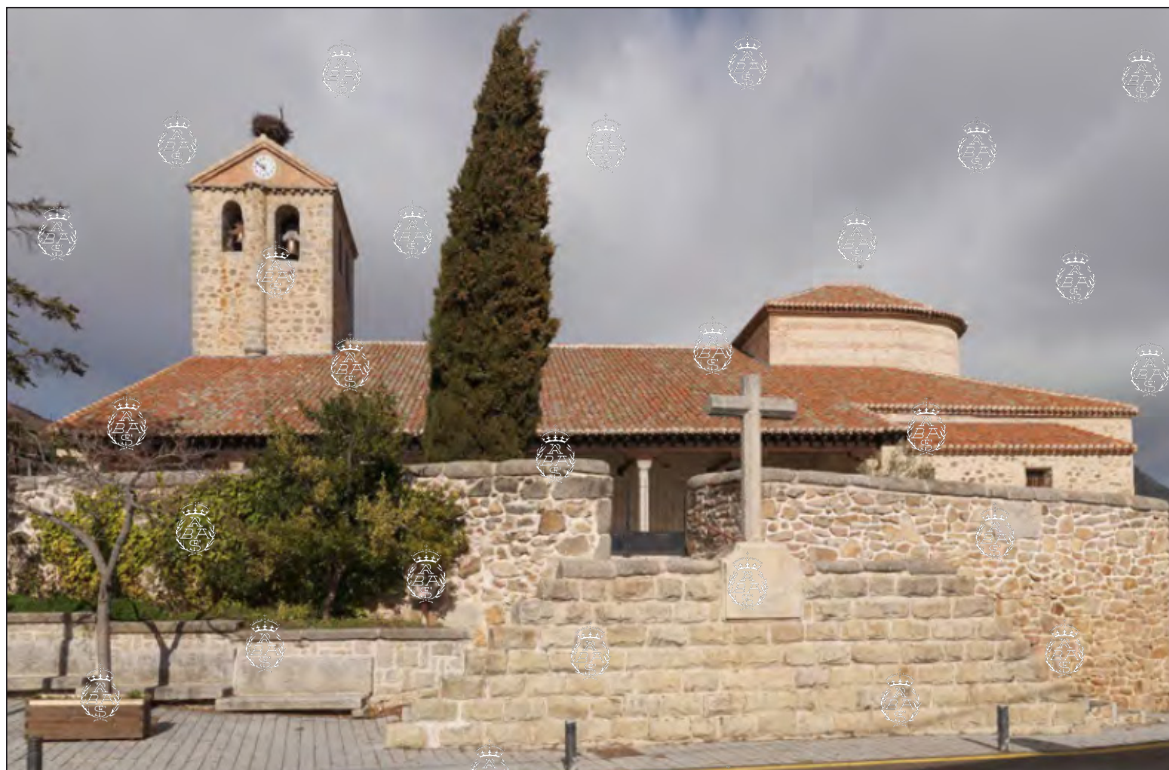
Lado sur de la parroquial de Bustarviejo, sobre la calle Real, coincidente con el trazado de la carretera M-610. Foto: Comunidad de Madrid.
