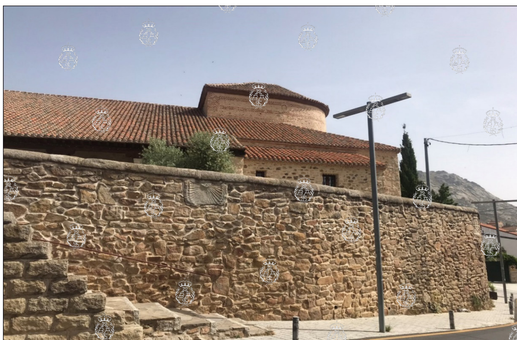
Detalle del cerramiento que envolvió en su momento todo el perímetro de la iglesia parroquial de Bustarviejo. En el muro se incorporaron algunas piezas labradas procedentes de distintos lugares. Foto: P. Navascués (2022).
