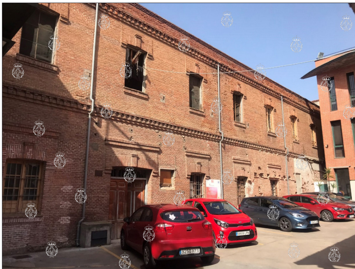
Fachada interior de la fábrica de harinas "La Esperanza". Foto: P. Navascués (2022).
