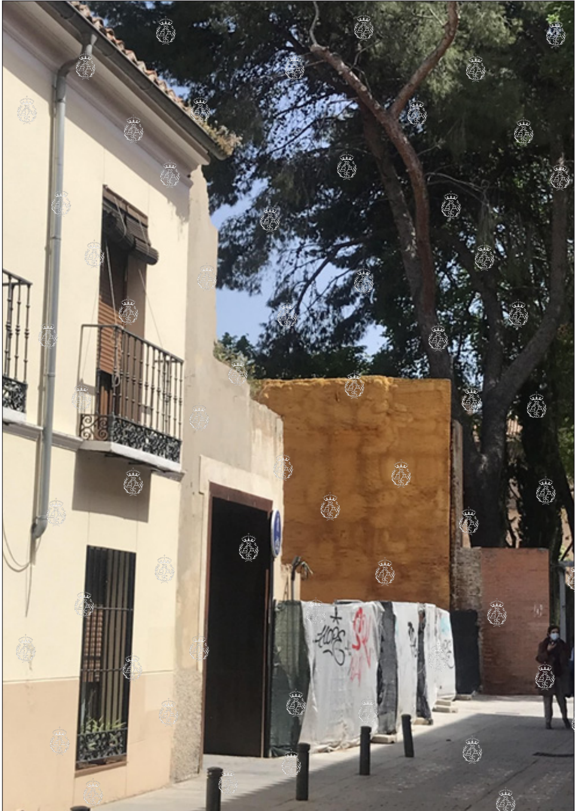
Imagen de la calle de Nebrija, rota por el derribo de la Casa de la Imprenta. Foto: M. C. Utande.
