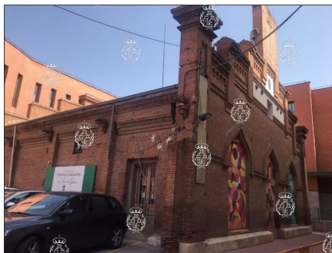
Central Eléctrica Complutense, formando parte del solar en que se levantó la Fábrica de harinas “La Esperanza”. Foto: P. Navascués (2022).
