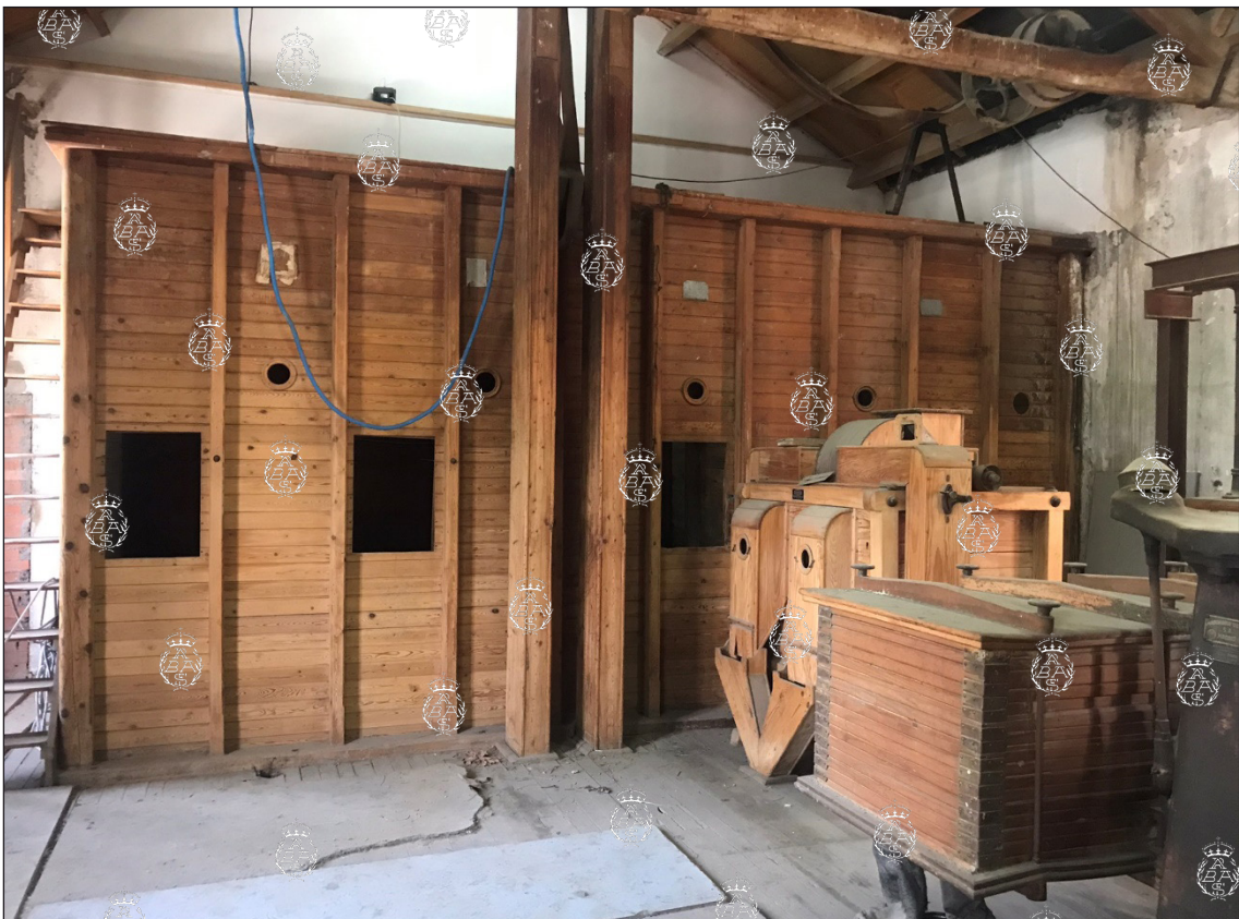
Tramullón de oreo y noria de cangilones que recorren interiormente toda la altura del edificio. Foto: M. C. Utande (2022).
