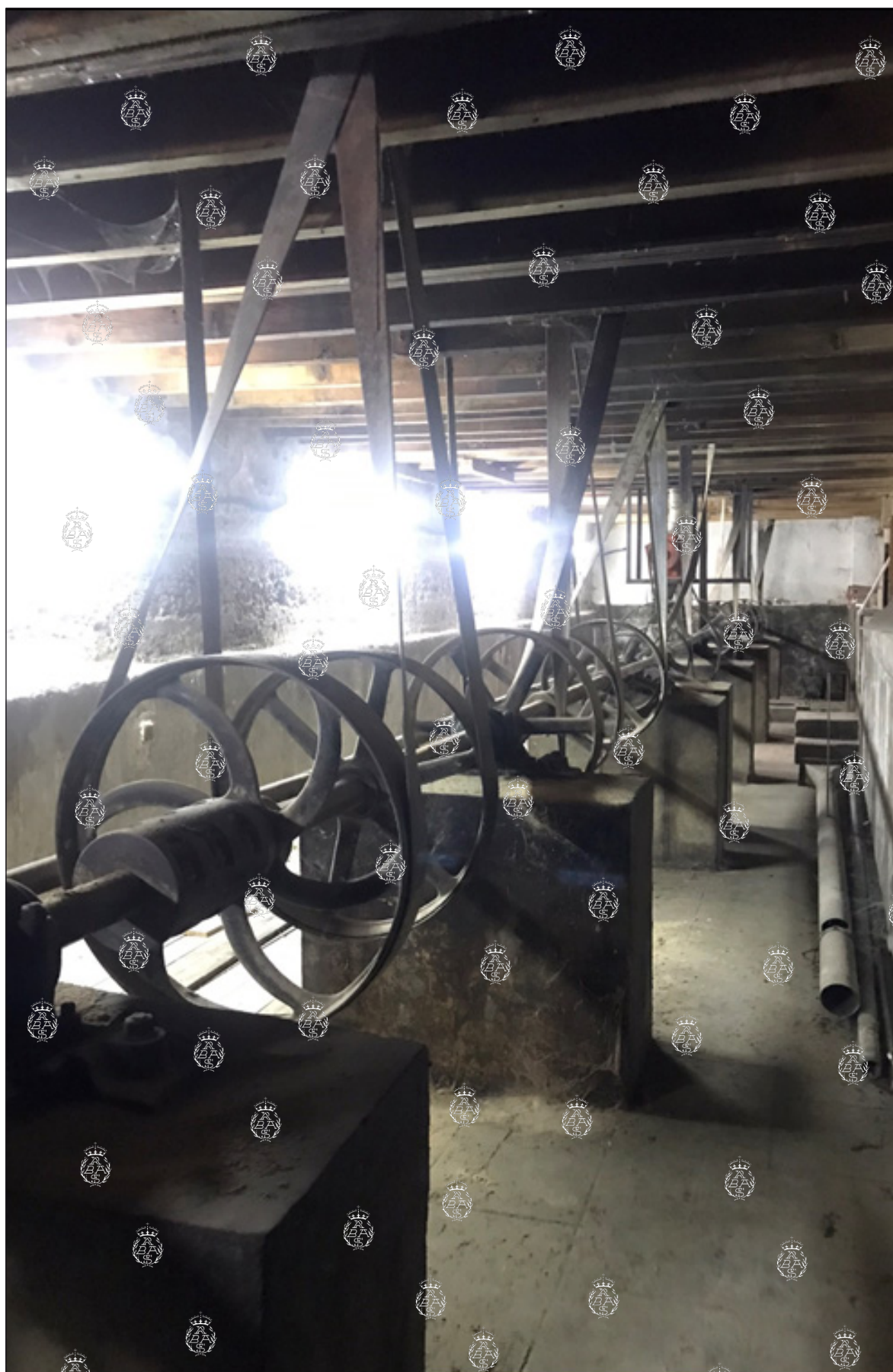
Planta baja: árbol general de transmisiones. Foto: P. Navascués (2022).
