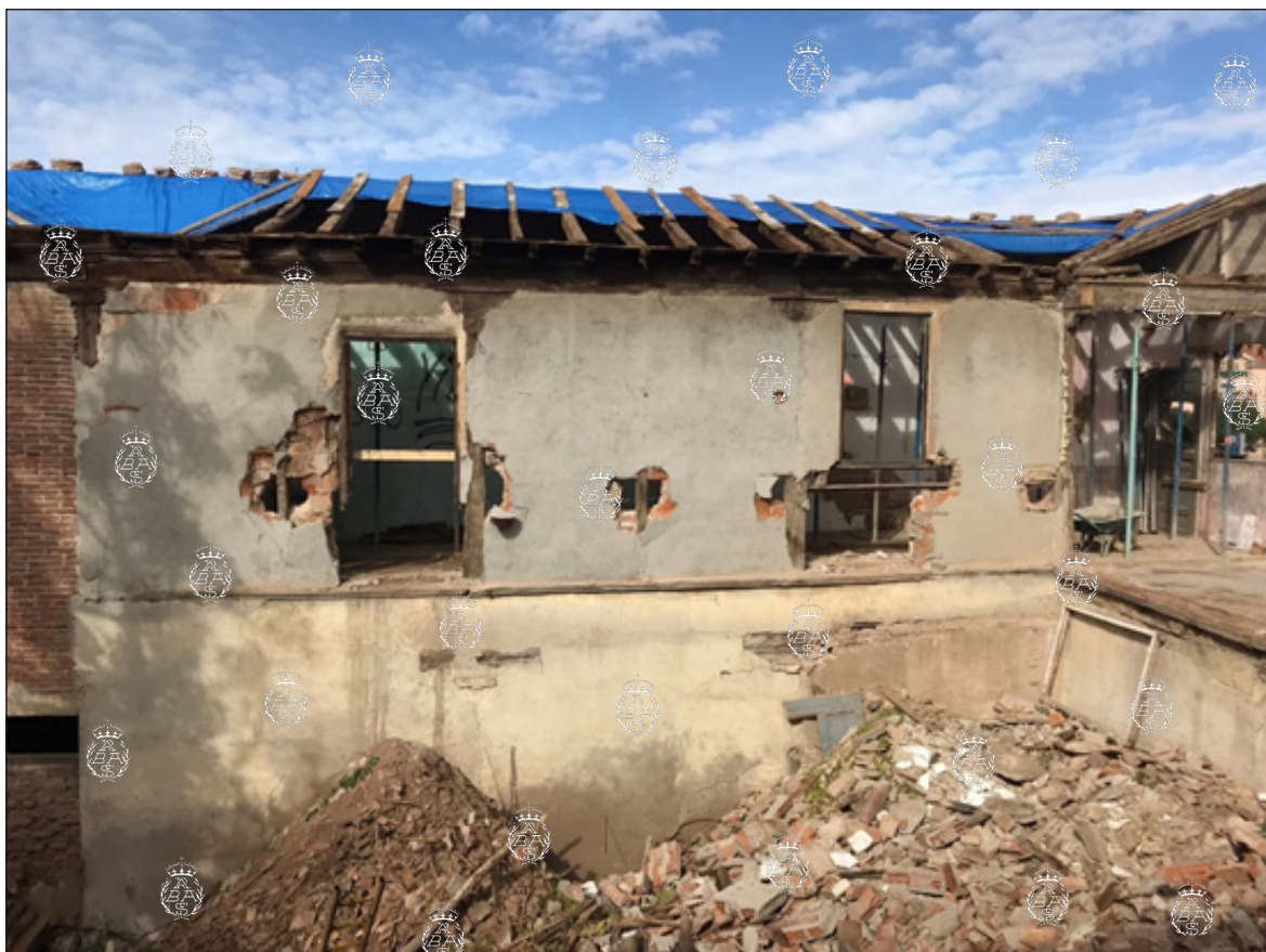
Patio durante el proceso de demolición. Foto: P. Navascués (2019).
