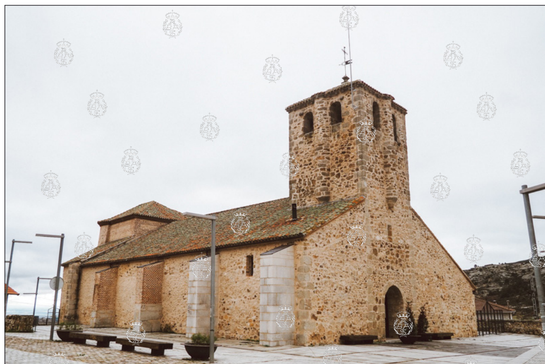
Fachada norte de la parroquia de Bustarviejo, después de su "restauración", destacando los dos nuevos contrafuertes en piedra para diferenciarlos de los originales que son de ladrillo. Foto: "Llegar sin avisar. Comunidad de Madrid".
