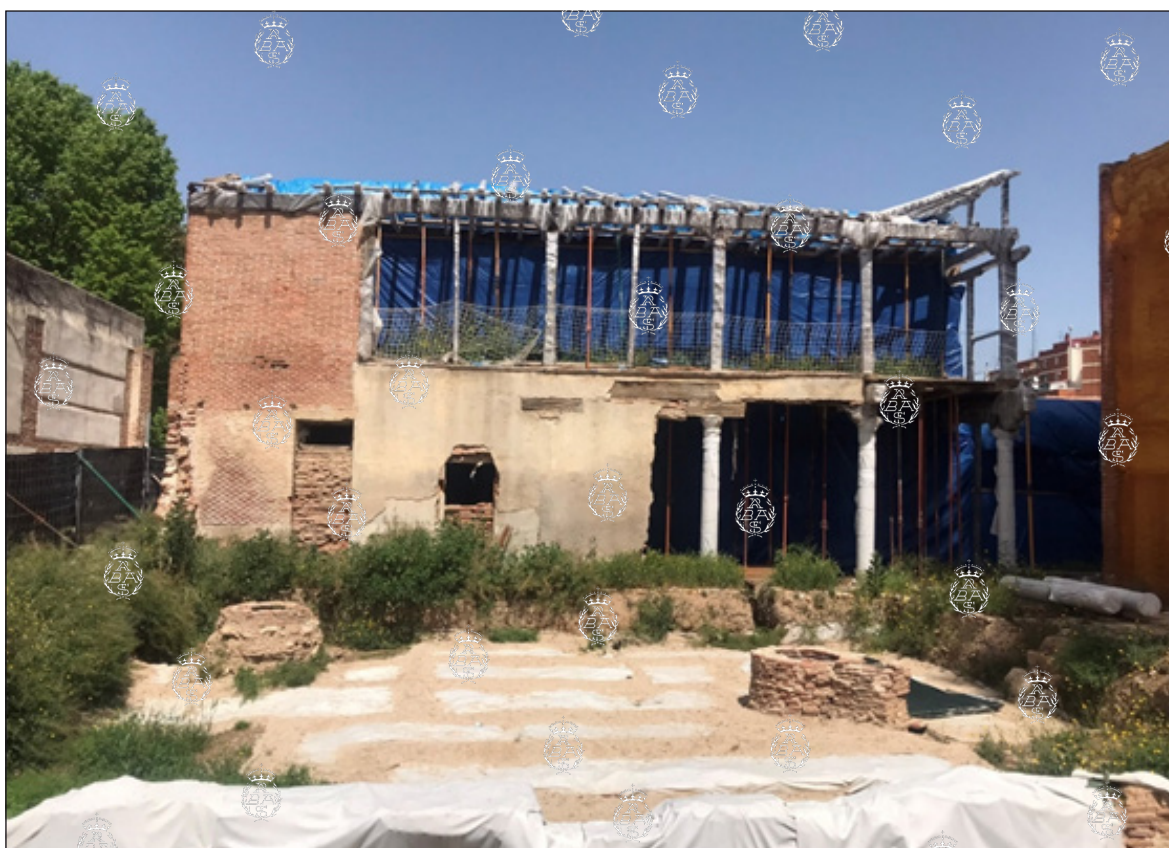
Vista actual del patio. Foto: P. Navascués (2022).
