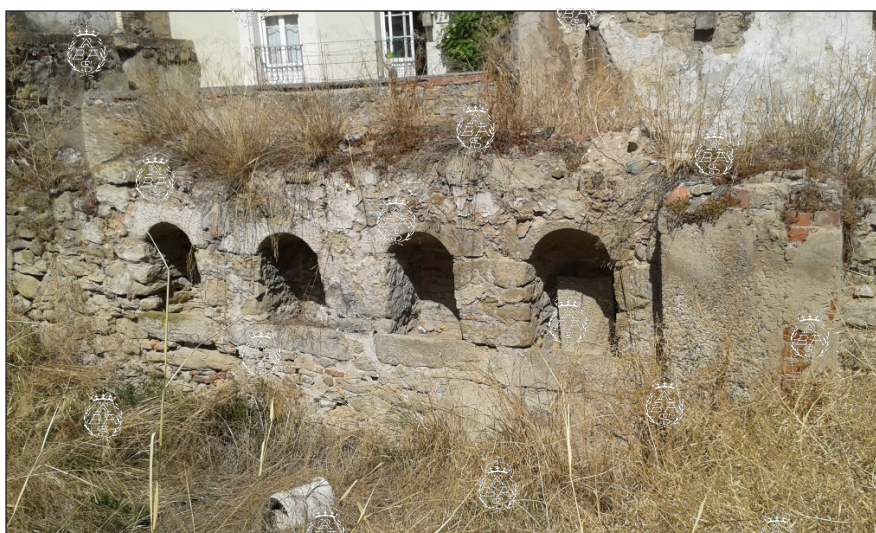
Restos arquitectónicos en el solar en el que se proyecta el Centro de Alto Rendimiento de Bosonit en Logroño (foto: B. Arrúe, septiembre de 2022).
