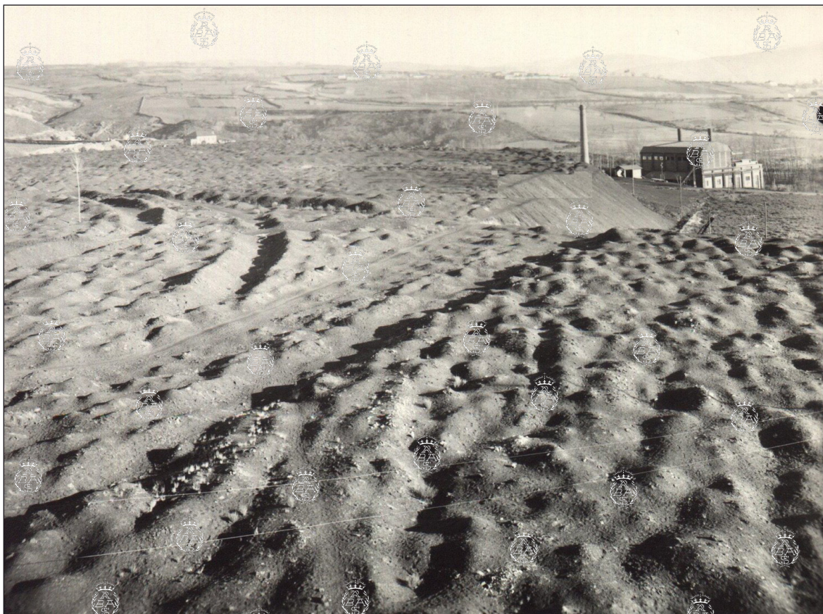
Vista de la MSP y su entorno hacia 1930. Obsérvese la formación de la Montaña de carbón , en el paraje inmediato que se conoció como La Escombrera (h. 1930). Foto de la Colección de la MSP.
