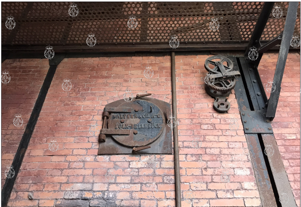
Detalle y registro de la caldera Walther . Foto: P. Navascués.
