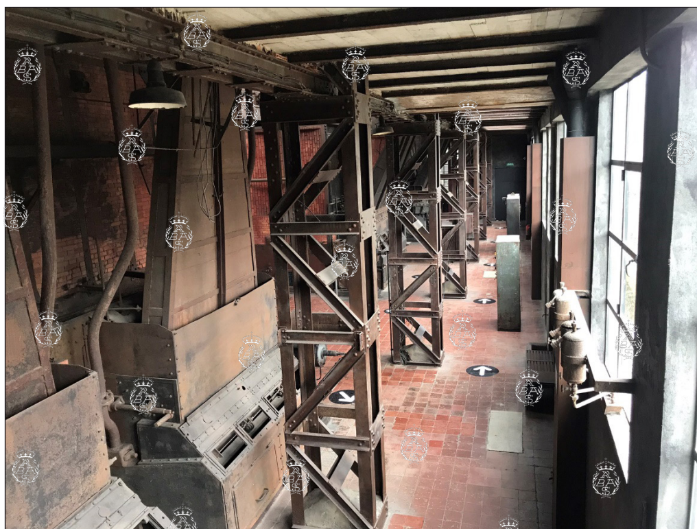
Detalle del interior de la nave de calderas, con las tolvas de alimentación de carbón. Foto: P. Navascués.
