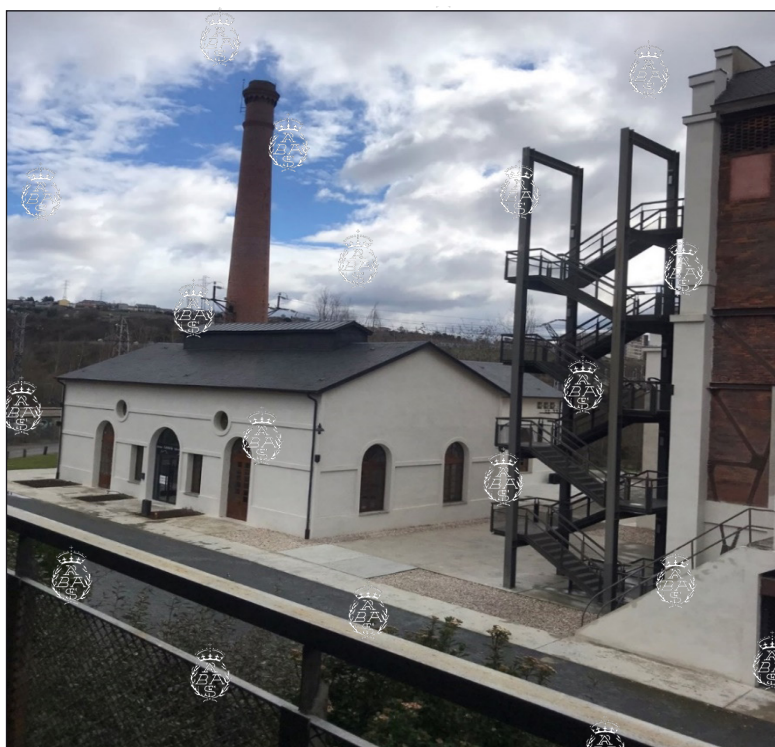
Vista actual del primer edificio y chimenea de la MSP, de hacia 1920. Hoy alberga oficinas y un restaurante. A la derecha, escalera de incendios de la nave de calderas. Foto: P. Navascués.
