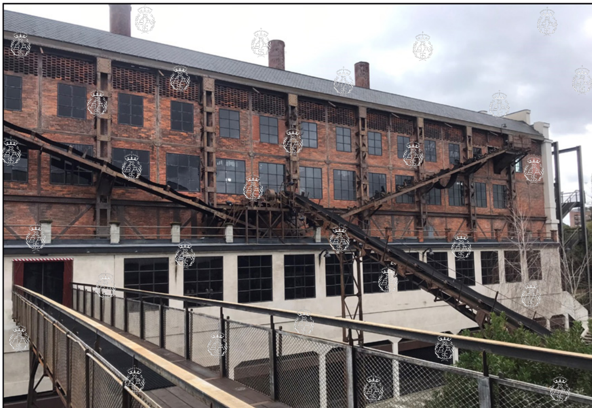
Fachada norte de la nave completa de calderas. Vista actual desde el descargadero de carbón, de donde parte la cinta transportadora. Foto: P. Navascués.
