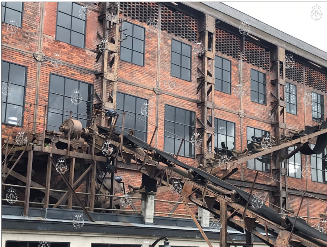
Detalle de la fachada de la nave de calderas dejando vista la estructura metálica y cerrados los paños con ladrillo. Foto: M. C. Utande.
