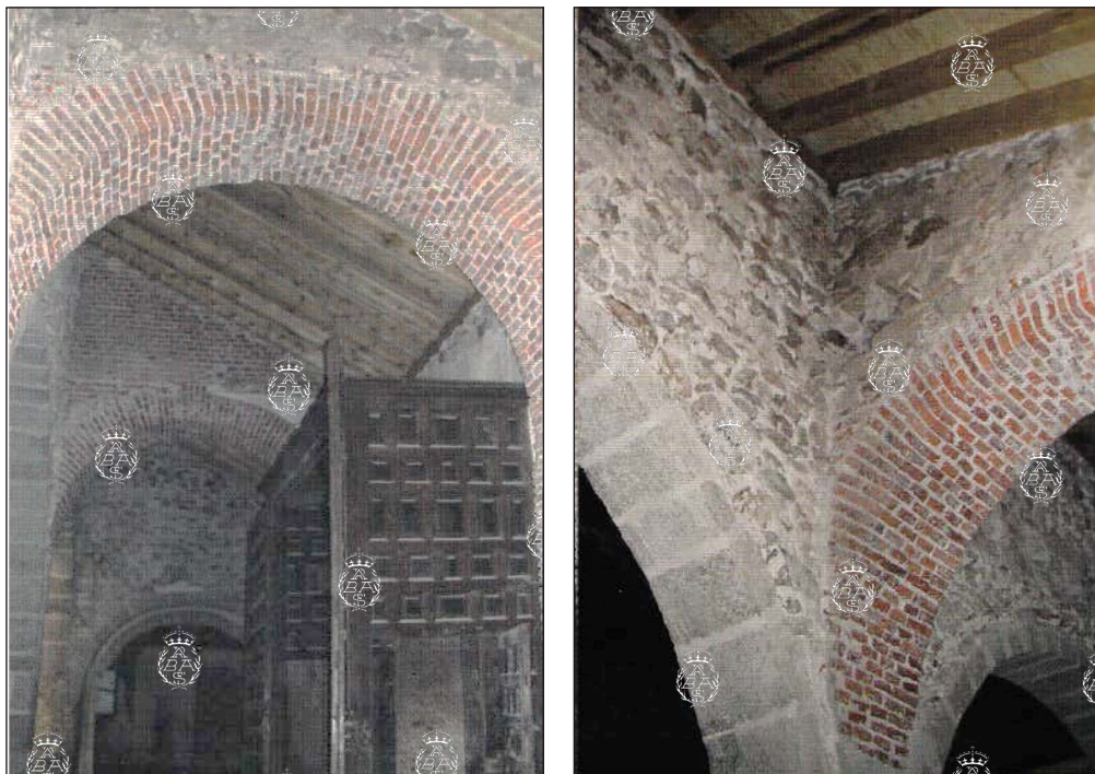
Detalles de los arcos de ladrillo en la nave de la Epístola, durante el proceso de “restauración” y antes de ocultar su fábrica con un enlucido que resta carácter al edificio, en lugar de dejar visto el ladrillo, tal y como estaban los arcos antes de llegar los restauradores que, en cambio, despellejaron algunas zonas para dejar visto el ladrillo, como en la embocadura parcial de una de las ventanas de la nave de la Epístola. Reproducidas en Bustarviejo recupera su historia... p. 86.
