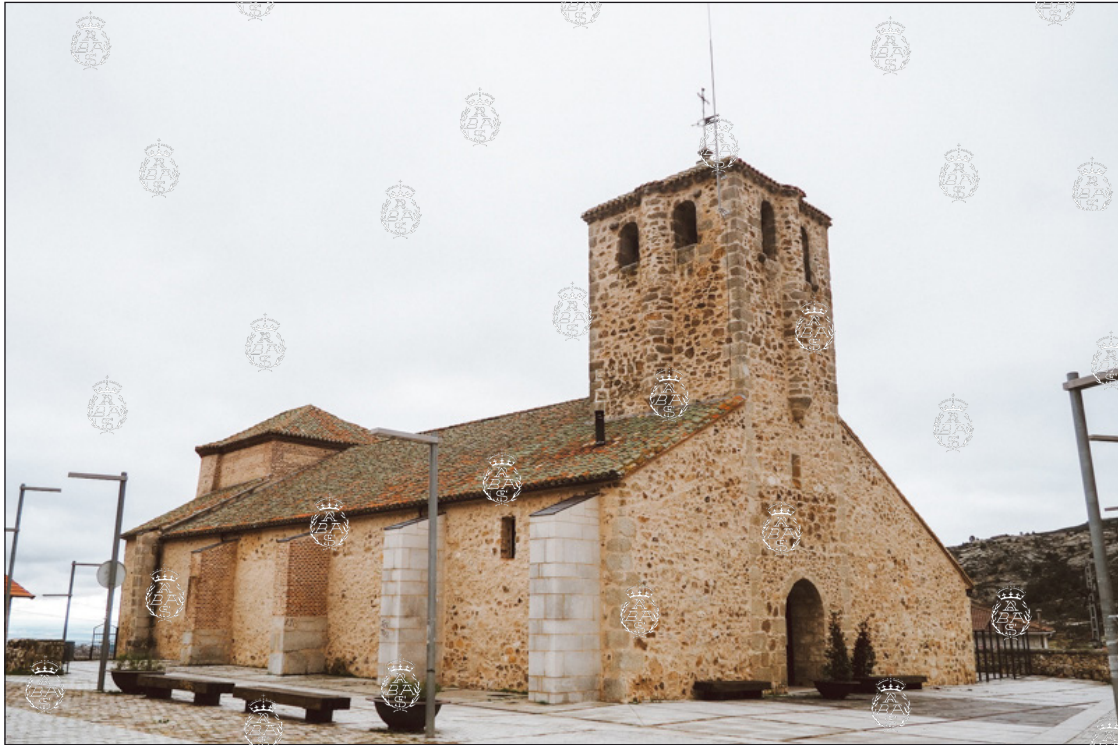
Fachada norte de la parroquia de Bustarviejo, después de su “restauración”, destacando los dos nuevos contrafuertes en piedra para diferenciarlos de los originales que son de ladrillo. Foto: “Llegar sin avisar. Comunidad de Madrid”.
