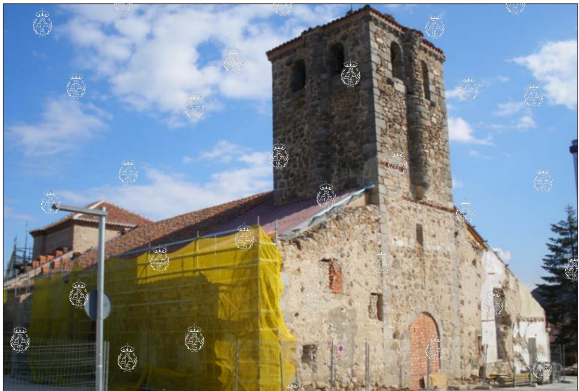
La parroquia de Bustarviejo durante las obras de restauración. Reproducido por E. Martínez Borrell en “Técnicas y sistemas de edificación”, ETSAM (UPM) 2010, p. 53.
