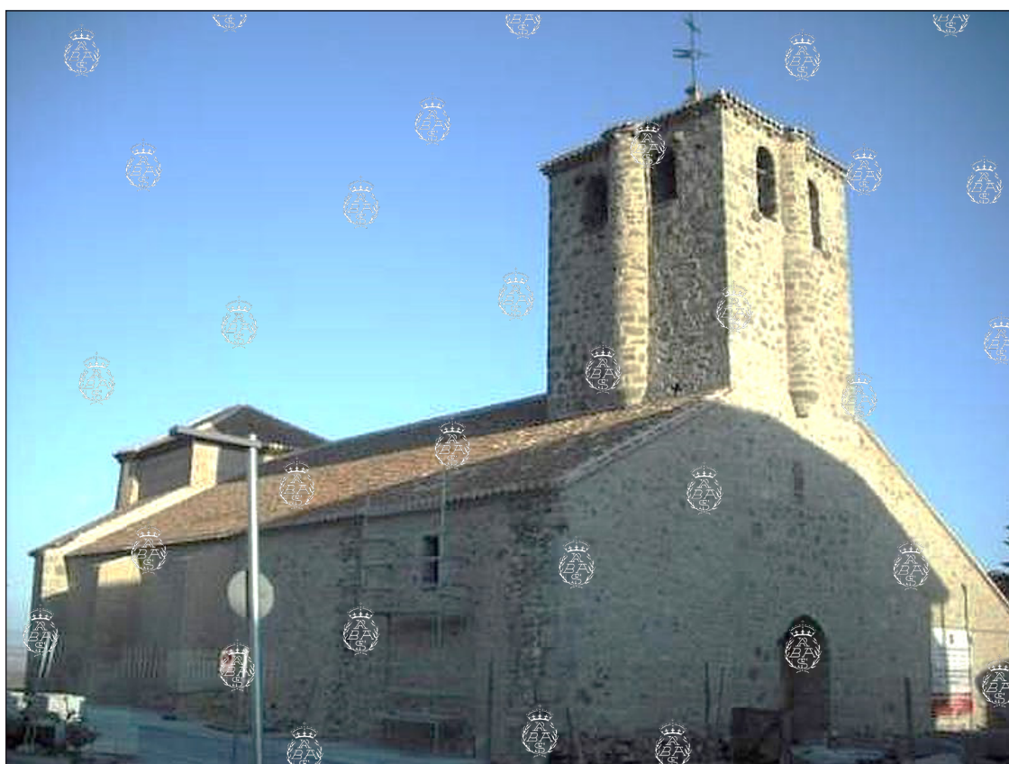
Fachada norte de la parroquia de Bustarviejo después de las demoliciones llevadas a cabo en 2006. Foto: Santiago López-Pastor Rodríguez.
