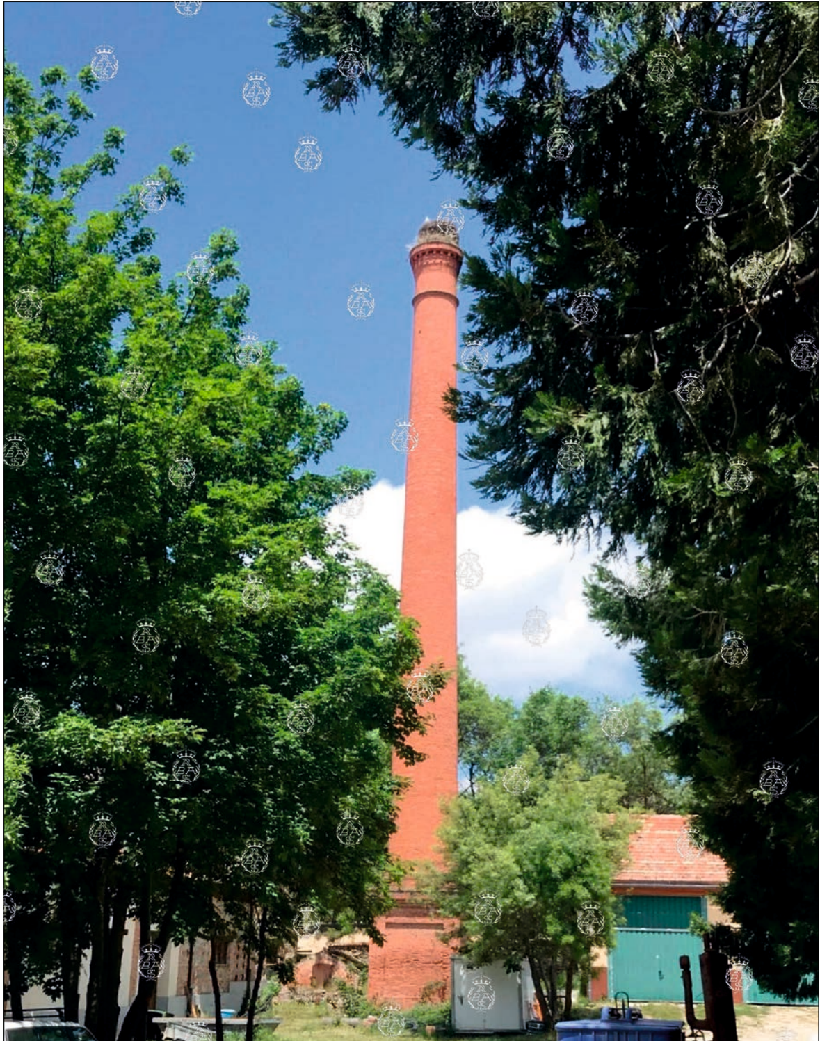
Chimenea del Real Aserrío. Foto: P. Navascués.
