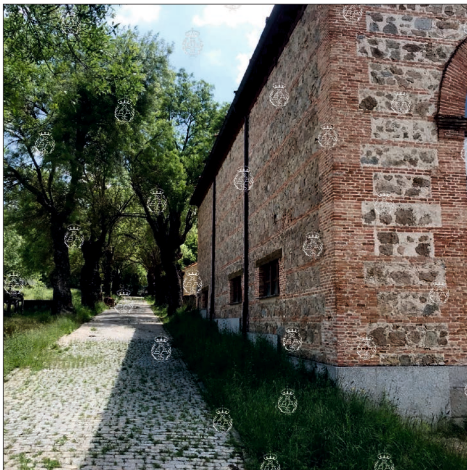
Fachada lateral de la sala de la máquina de vapor y paseo inmediato. Foto: P. Navascués.
