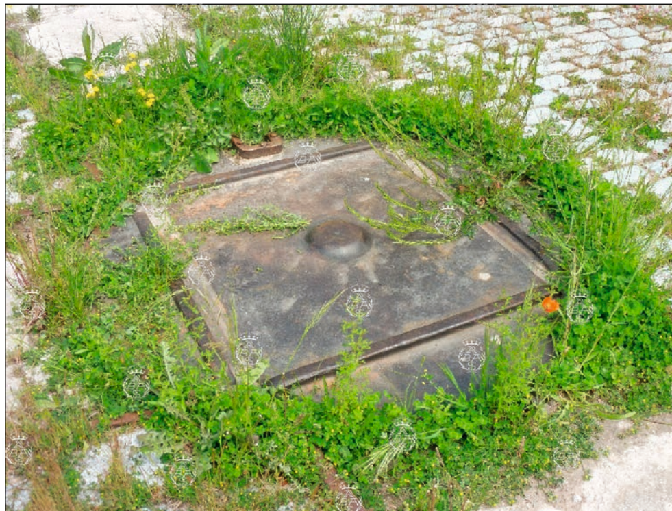
Plancha giratoria del tendido viario. Foto: E. Nuere.
