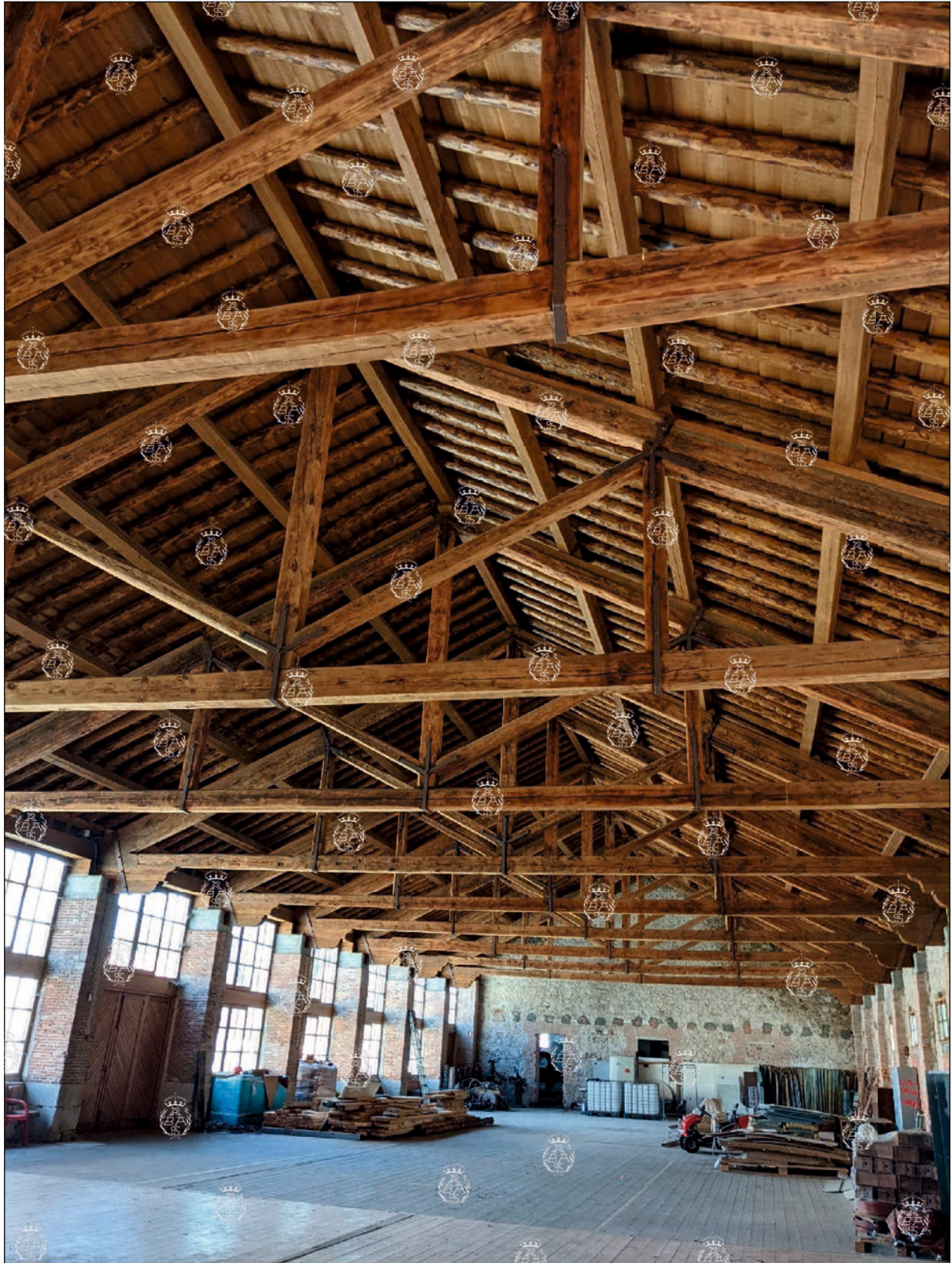
Antigua sala de máquinas del Real Aserrío. Foto: M. C. Utande.
