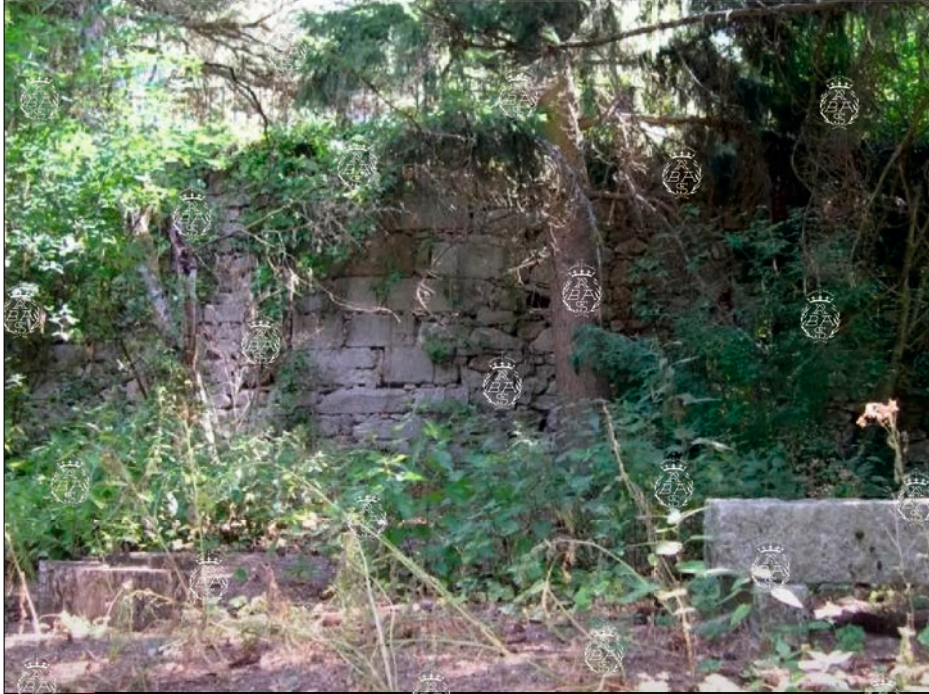
Restos de la traída de aguas para la primera máquina hidráulica. Finca “Máquina Vieja”. Foto: autor desconocido.
