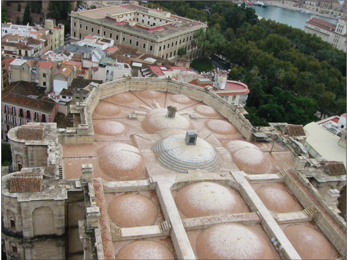
Trasdós de las bóvedas de la catedral de Málaga, en 2004. Foto: P. Navascués.
