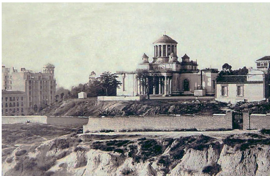
Vista del Observatorio Astronómico de Madrid con el cuerpo de escaleras ya enterrado y antes de la construcción en 1939 de los nichos convexos cubiertos por medias cúpulas adosados al cuerpo oriental del edificio, tal como hoy se mantienen.
